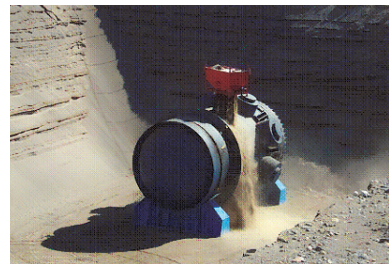
► Stockage de la cuve sous pression du réacteur de la centrale nucléaire de Trojan. Centre d'entreposage des déchets radioactifs de Richland, Washington, États-Unis. [Photo : US Ecology, Inc.]
