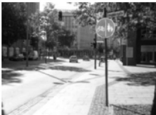
Un cheminement piétons-cycles est un espace (uni- ou bidirectionnel) réservé aux cyclistes et aux piétons le long de la chaussée. Il peut être mixte, les cyclistes et piétons pouvant l'utiliser dans toute sa largeur, ou divisé entre les deux groupes d'utilisateurs par une séparation visuelle (marquage) ou par une différenciation de revêtement.
