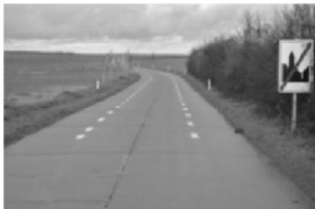
La chaussée comprend une voie centrale réservée à la circulation automobile et deux voies latérales pour les cyclistes et les piétons. Les véhicules motorisés n'utilisent la bande latérale que pour effectuer des dépassements ou des croisements.
