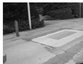
Différence de niveau entre la plaque d'égout et la surface de la chaussée
